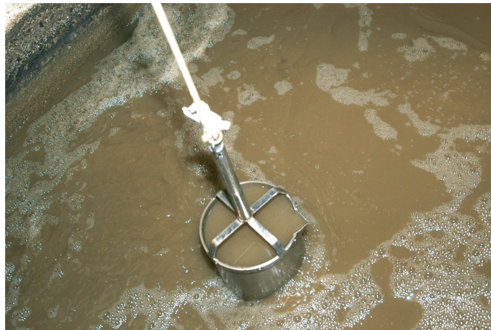
ばっ気槽から活性汚泥を汲むところ ©H.OOSAKI
